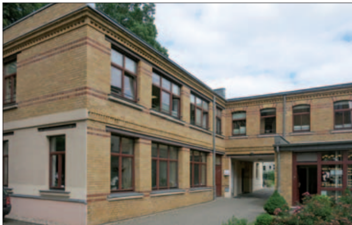
Hofgebäude des Ärztehauses, am 14. Juli 2021, früher Fabrik- und Wohnräume
